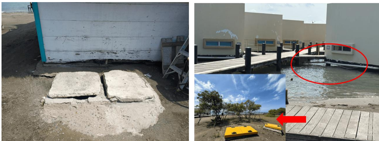
Figura 6-9. Pozas sépticas identificadas en restaurantes y marina de puerto velero.
