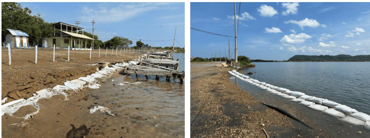
Figura 6-11. Estructuras de protección costera artesanal identificados en la playa de puerto velero.
